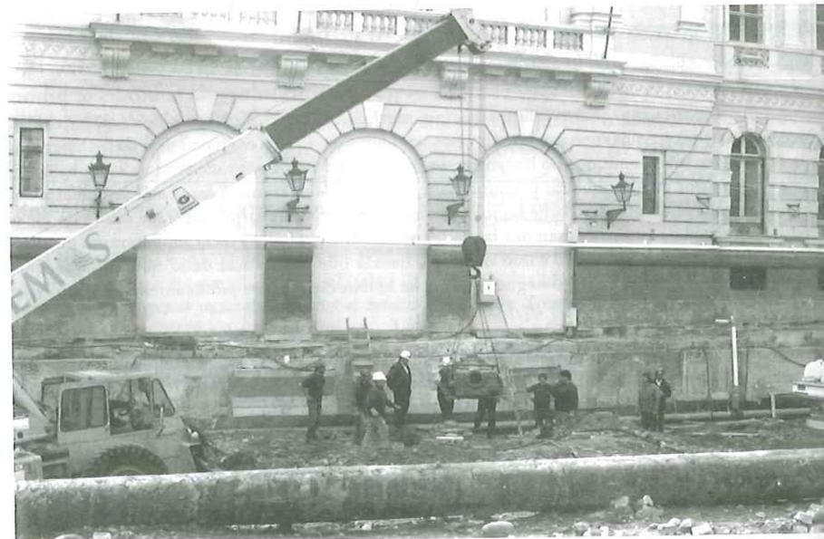
Excavaciones frente a la Municipalidad de Santiago en ampliación de la Línea 5 del Metro, en que se observan tres etapas del agua potable de Santiago: 1. Caja decantadora del siglo XVIII, elevada por grúa de EMOS; 2. Tubería de hierro fundido en primer plano, utilizada en los siglos XIX y XX; y 3. Cañería plástica de PVC adosada a la base de la Municipalidad. Foto gentileza de la arqueóloga Claudia Prado B.
